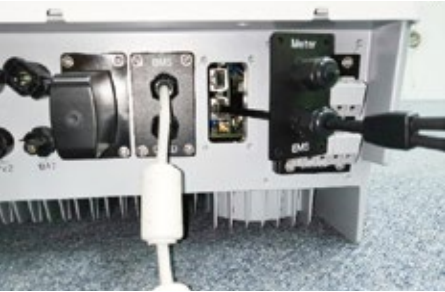
Schritt 3: das Kabel des neuen Zählers und die EMS-Abdeckung am RJ45-Anschluss des ET anbringen
