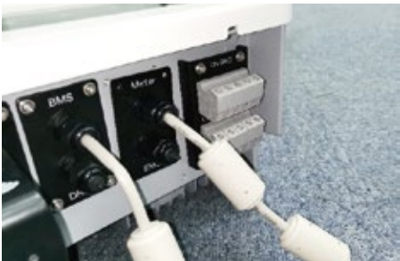
Schritt 2: den Originalzähler und die EMS-Abdeckung vom ET entfernen
